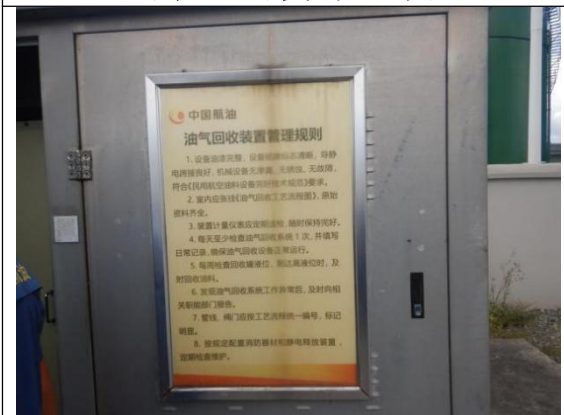
油气回收装置
