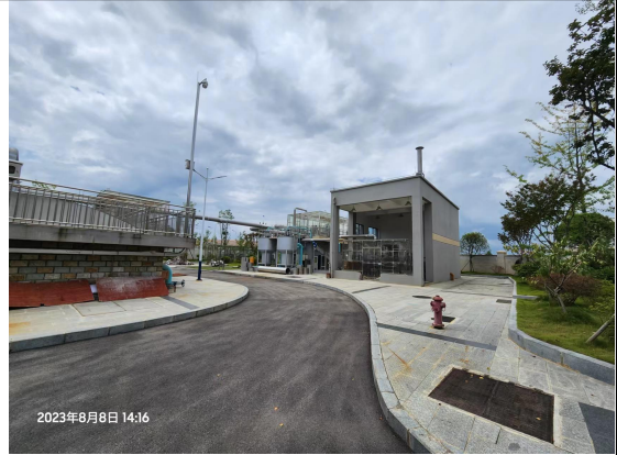
污水再生处理回用厂
