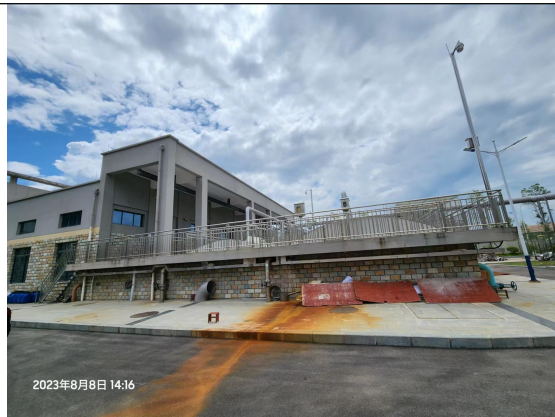
污水处理系统（密闭式）
