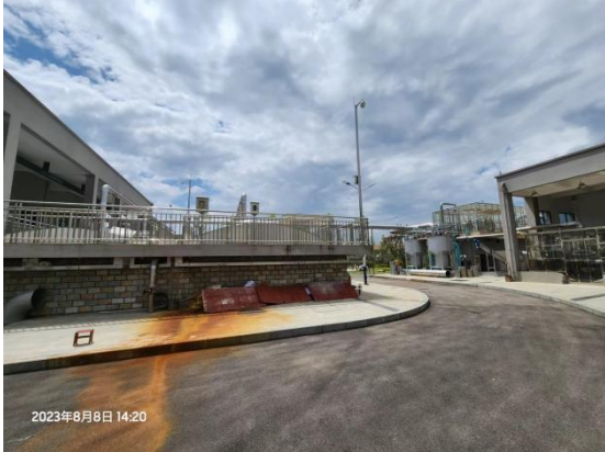
污水再生处理回用厂
