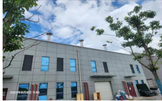
燃气锅炉排气筒（供水站内）
