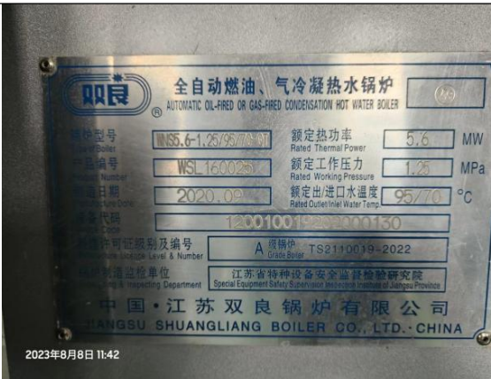
燃气锅炉铭牌（供水站内，同型号 3 台）
