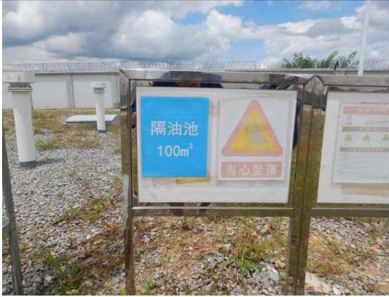
油罐区隔油池
