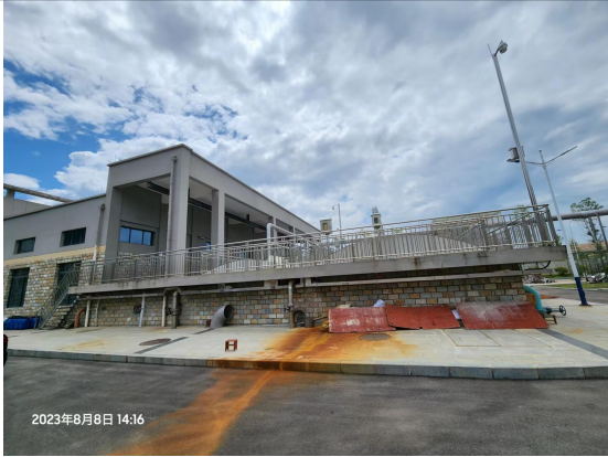
污水再生处理回用厂
