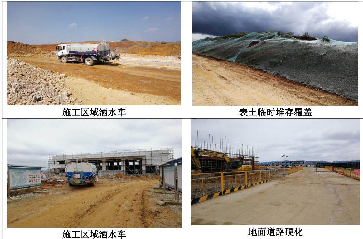
图 6.1-1 施工期大气污染防治措施
